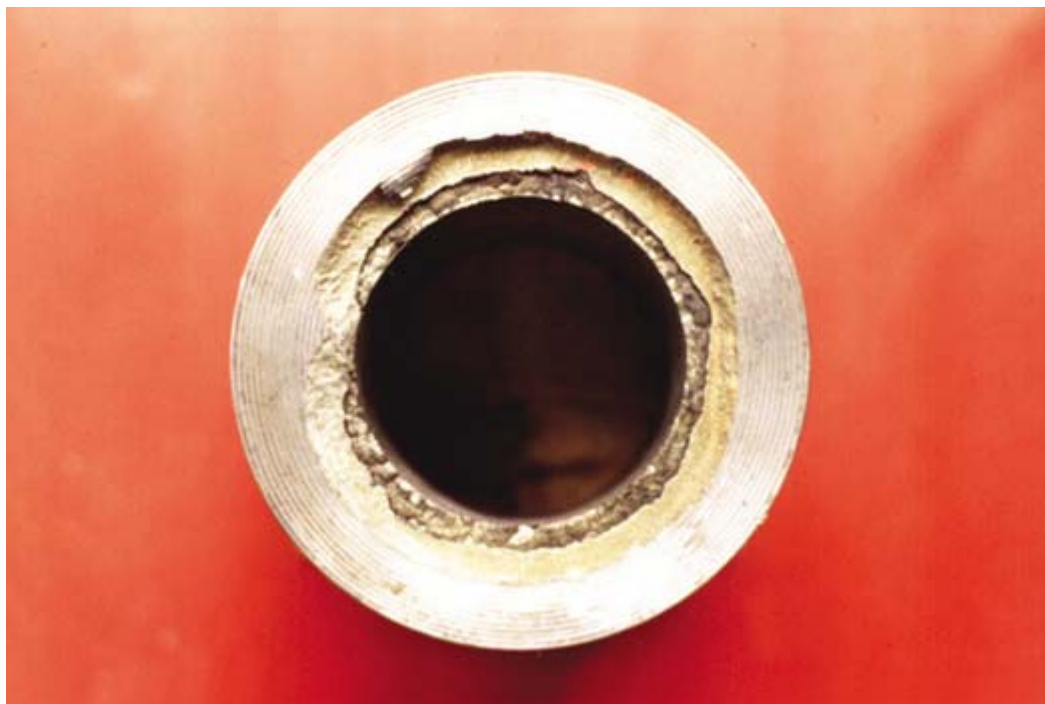
FIGURA 8 – CORROSÃO POR AERAÇÃO DIFERENCIAL, EM COMPONENTE DE FLANGE, OCACIONADA POR JUNTA QUE POSSIBILITOU A FORMAÇÃO DE FRESTA
