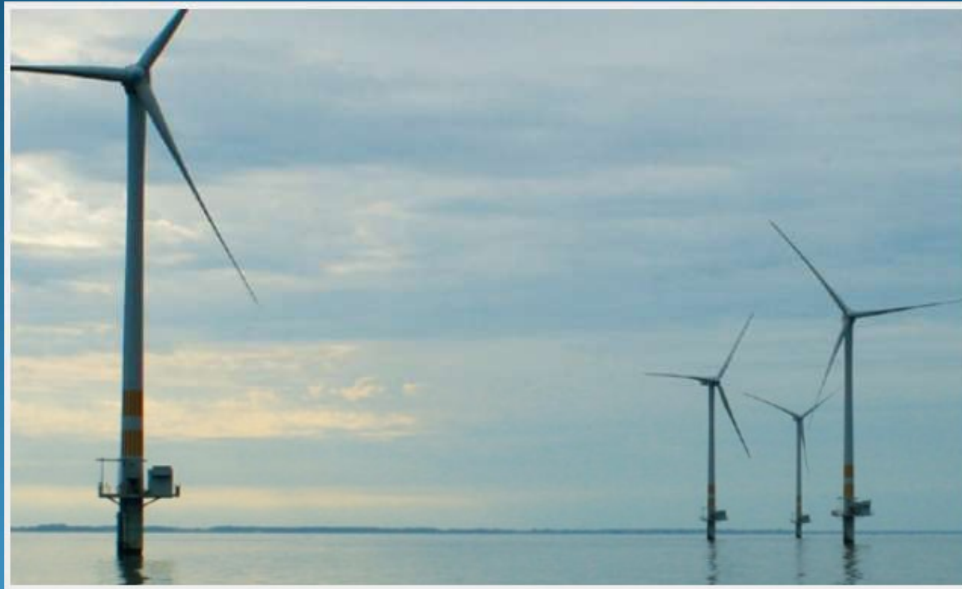
Figura 4 – Parque Eólico em alto-mar - Instalação Off-Shore – Situação comum na Europa
