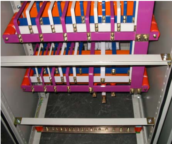
Figura 21 – Montagem com barragem pintados Identificados nas cores padrões.
