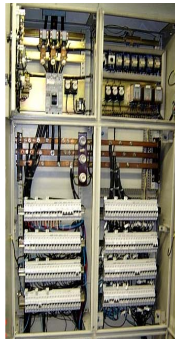
Figura 9 - Conjunto do tipo multi-modular - Cliente: Augusto Velloso – Obra: Integração Luz
