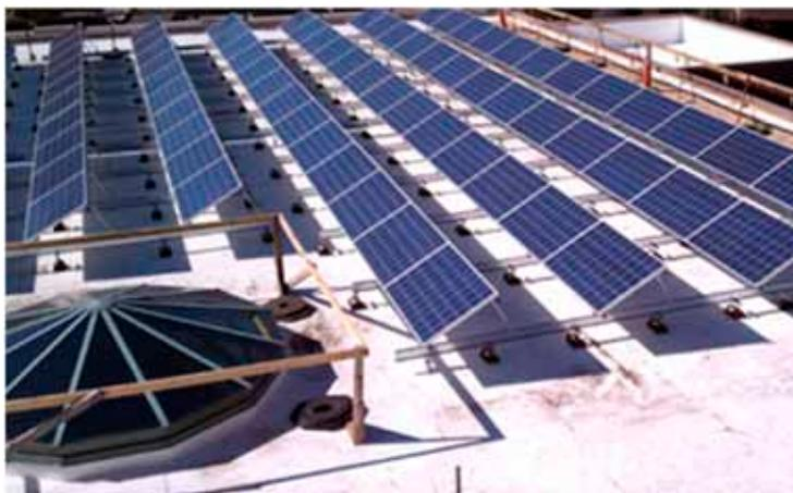
*Fig. 5.22 – Sistema de fixação em telhado plano. A distância entre as fileiras é definida a partir do trade-off entre perdas por sombreamento e área aproveitada.*
