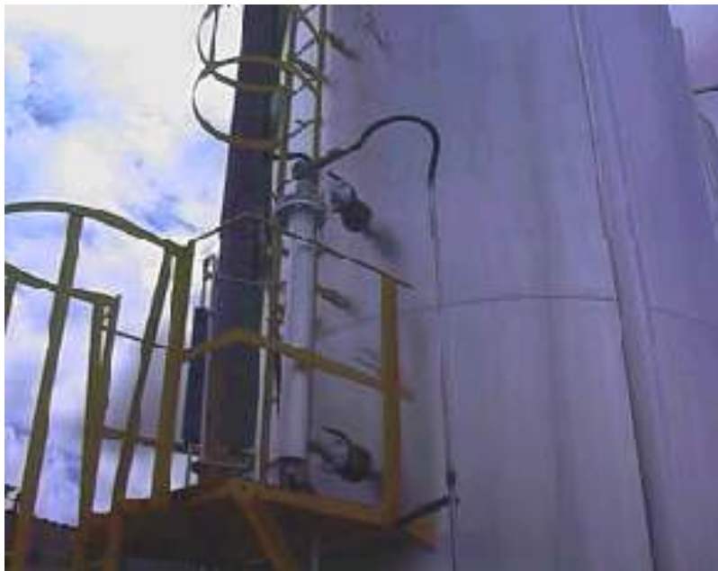
Medição de nível de interface (Água salgada/óleo)
