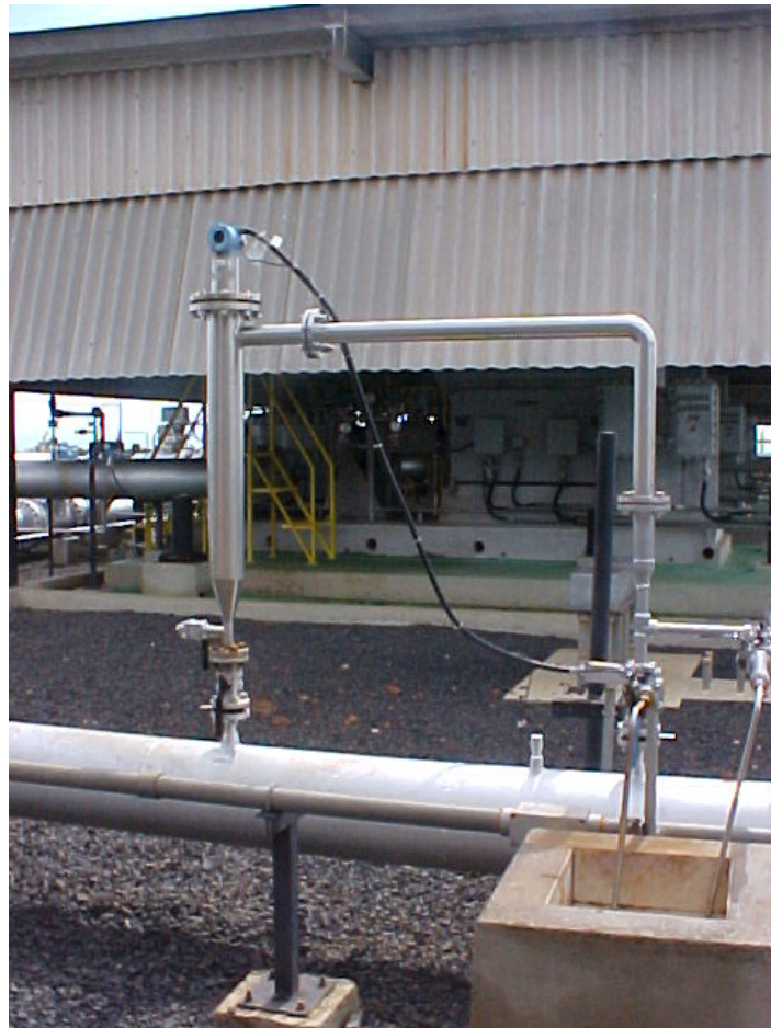
Captação do fluido de processo através do tubo de Pitot
